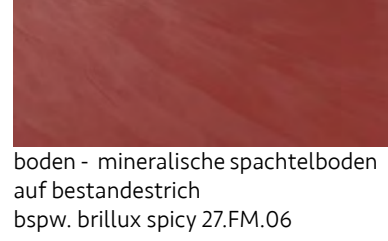
boden - mineralische spachtelboden auf bezaendestrich bspw. brillux spicy 27 FM.06
